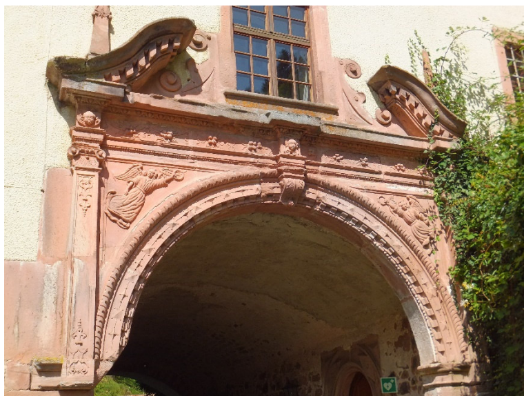
(4) Das Renaissance-Portal, der ehem. Hauptzugang
