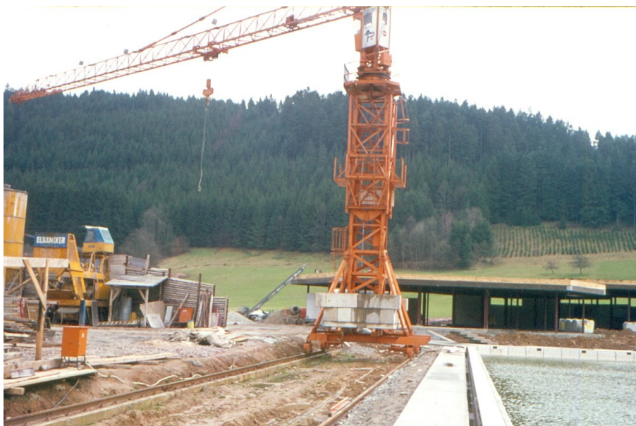
Die Bauarbeiten sind noch in vollem Gange
